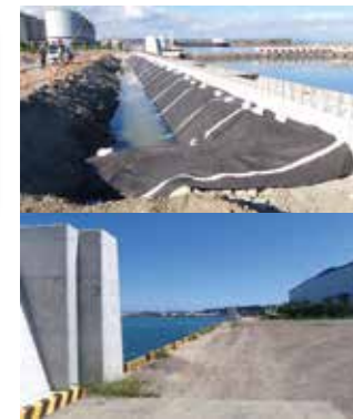
御前崎港防波堤工事
